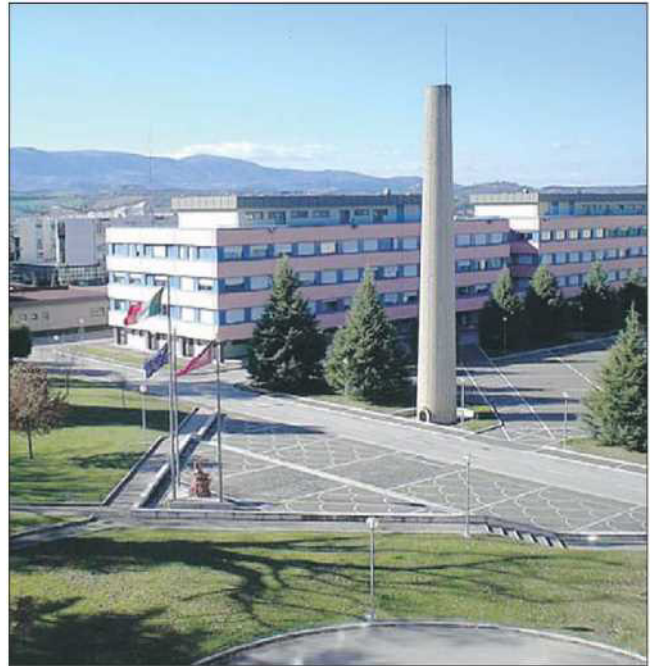
Scuola di polizia Accordo raggiunto per la sede di viale Trento e Trieste
